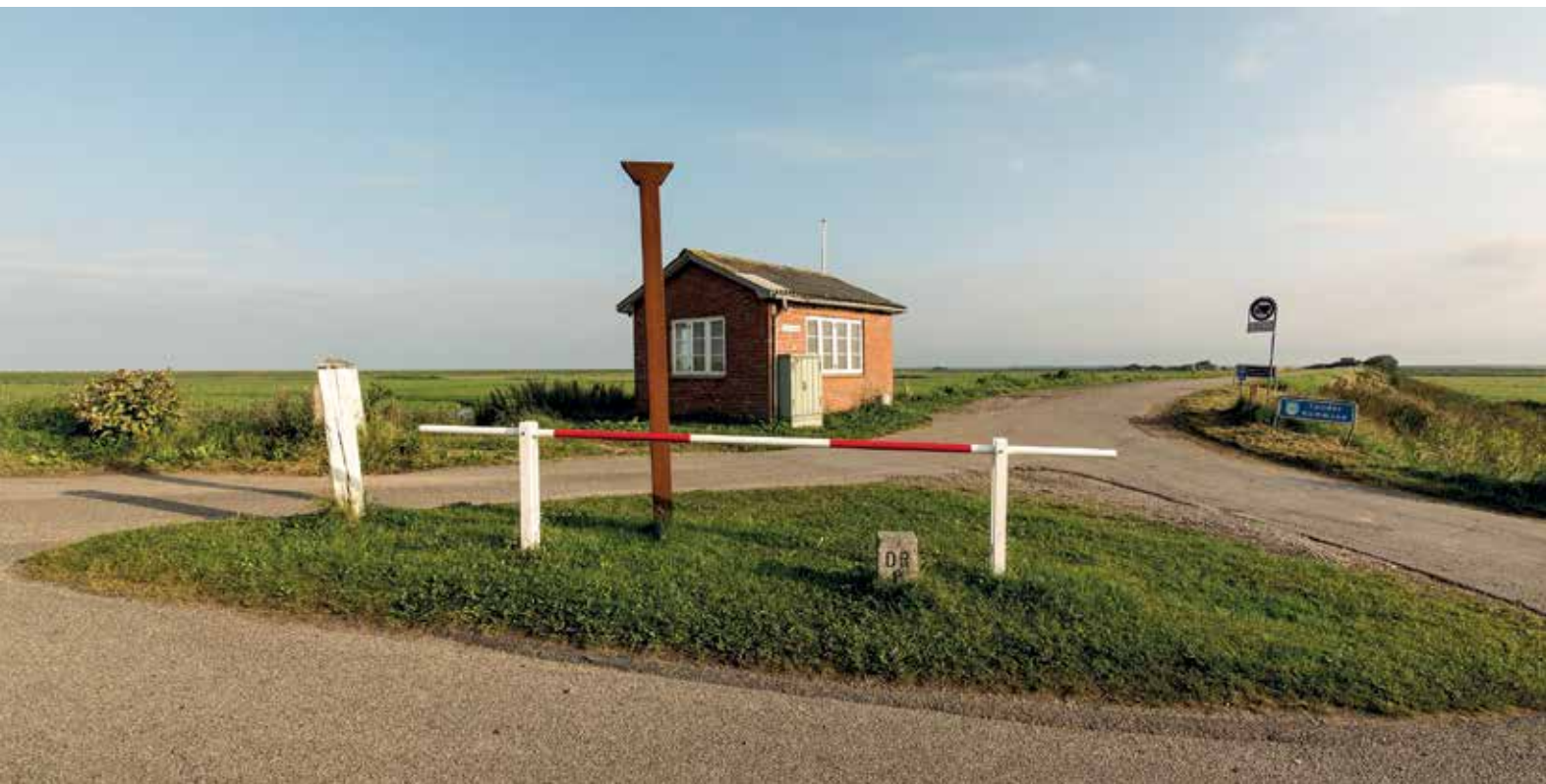
Grænsebommen ved Siltoftvej, Højer.
