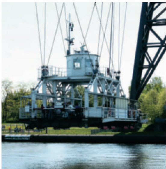
Svævebanen ved højbroen over Kielerkanalen.
