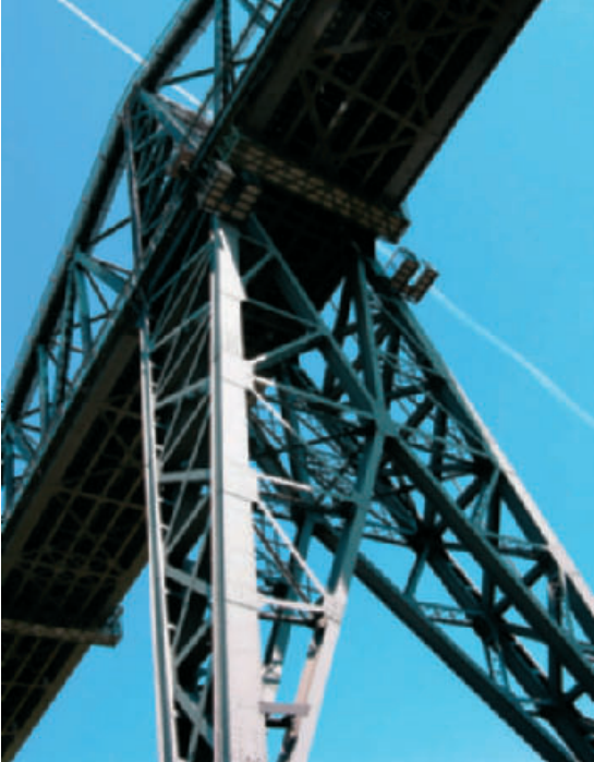
Detalje fra togbroen over Kielerkanalen i Rendsborg.
